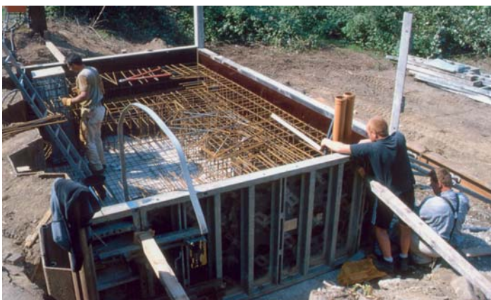
Bild 24: Bewehrung des Betonfundaments Fig. 24: Reinforcement of the concrete foundation
