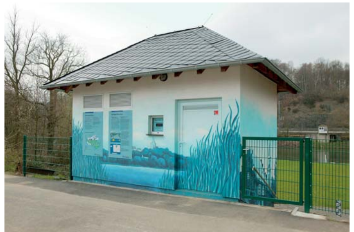
Bild 26: Der neue Pegel Wetter/Ruhr nach abgeschlossenem Umbau Fig. 26: The new gauging station at Wetter/Ruhr after reconstruction
