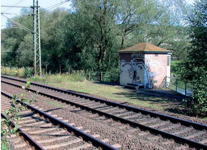
Bild 22: Pegel Wetter/Ruhr vor dem Umbau Fig. 22: The gauging station at Wetter/Ruhr before reconstruction
