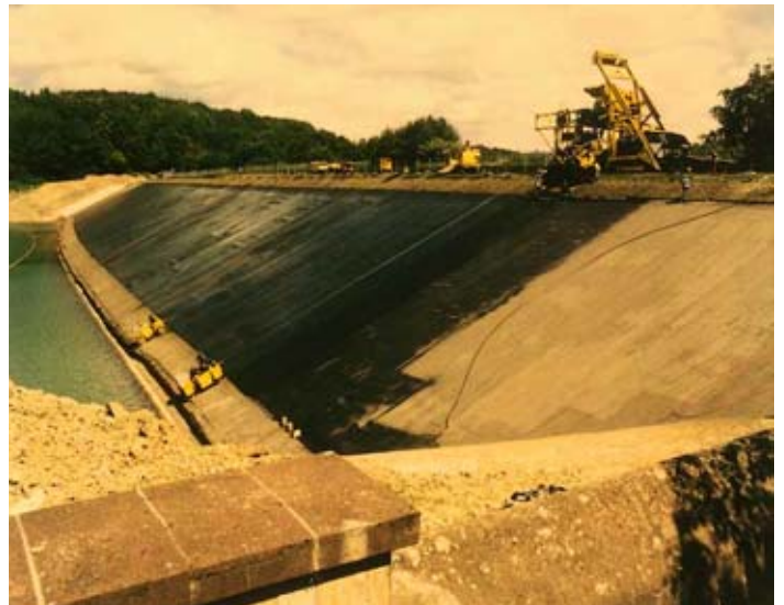
Bild 29: Bauausführung: Windenwagen mit Fertiger, Beschicker und Walze auf dem Hennedamm Fig. 29: Realization of the reconstruction: winch car with finisher, feeder and roller
