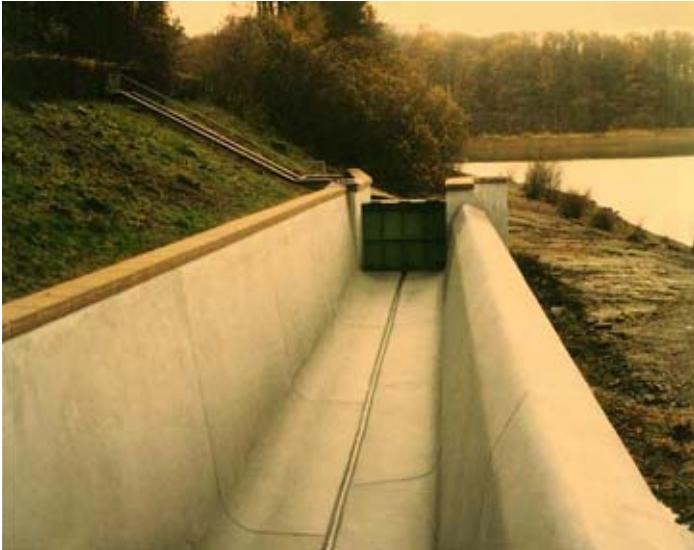
Bild 30: Sanierung des Betons der Hochwasserentlastung Fig. 30: Reconstruction of the spillway of the Henne dam
